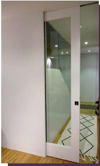
Puerta corredera de suelo a techo
