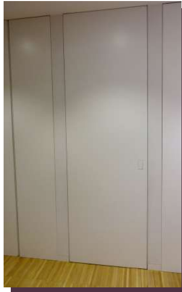
Puerta batiente sin marco de suelo a techo
